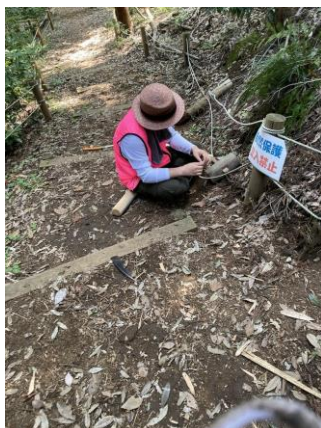
根元が腐っていてグラグラしていたので杭交換を行いました。
