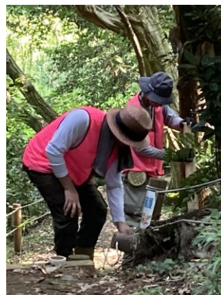
根元が腐っていてグラグラしていたので杭交換を行いました。
